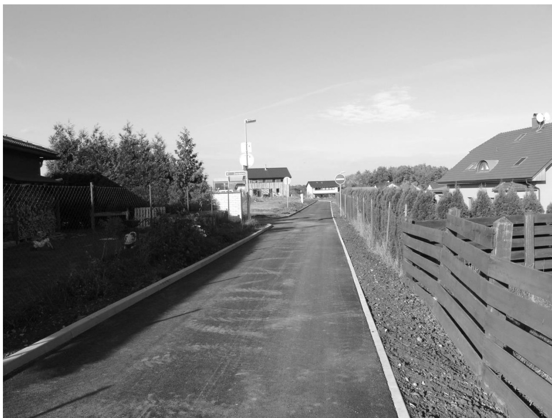
Hornátecká ulice po skončení stavby
