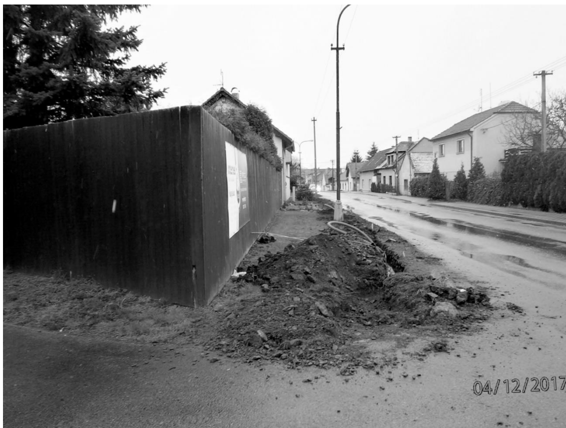
Rekonstrukce veřejného osvětlení – počátek prací
