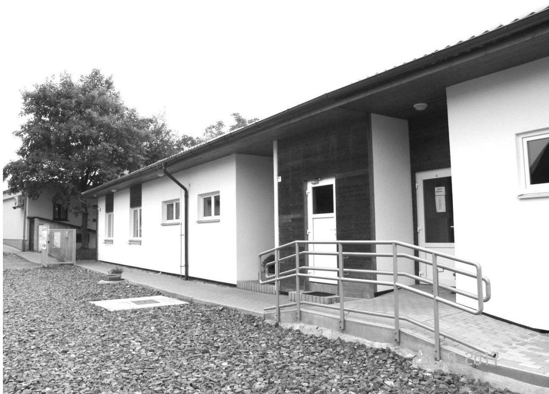
Budova MŠ Předboj
