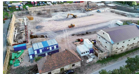
Stav staveniště v Bašti 23. 04. 2024.
