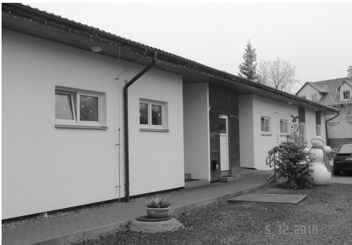
Budova MŠ Předboj
