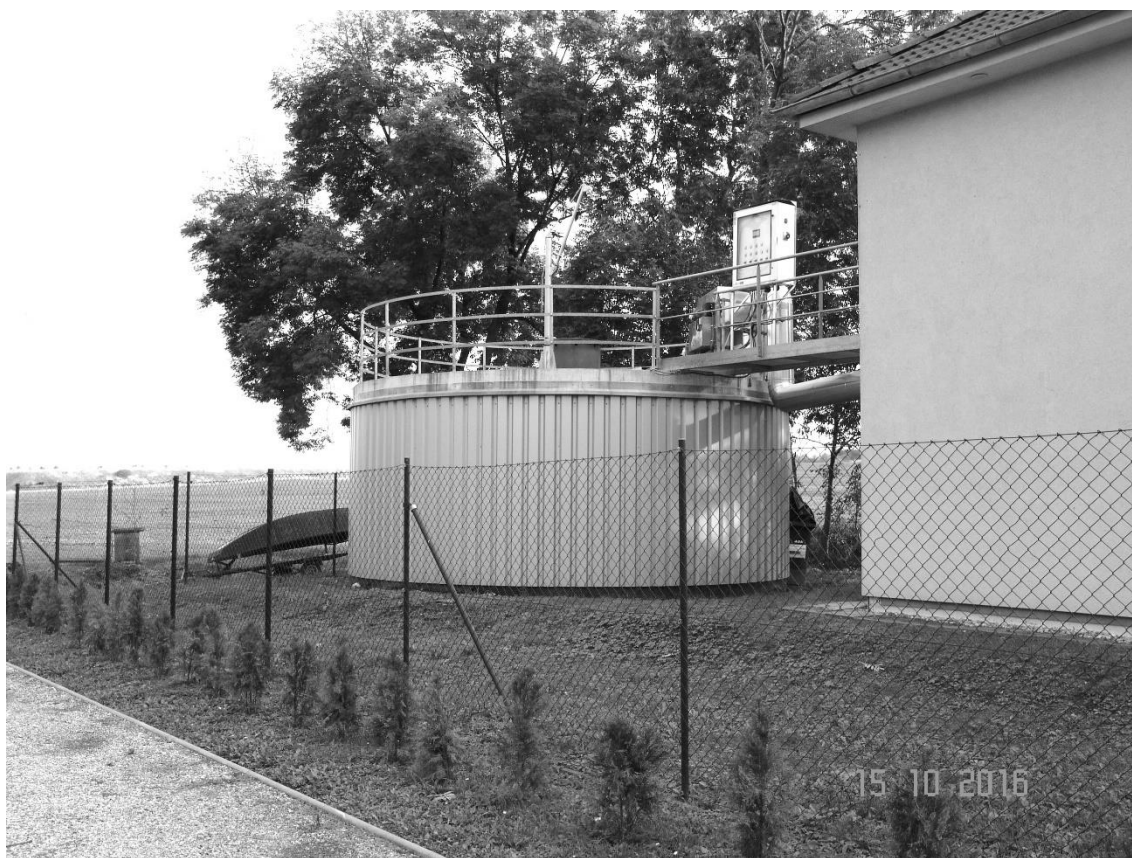
ČOV po rekonstrukci
