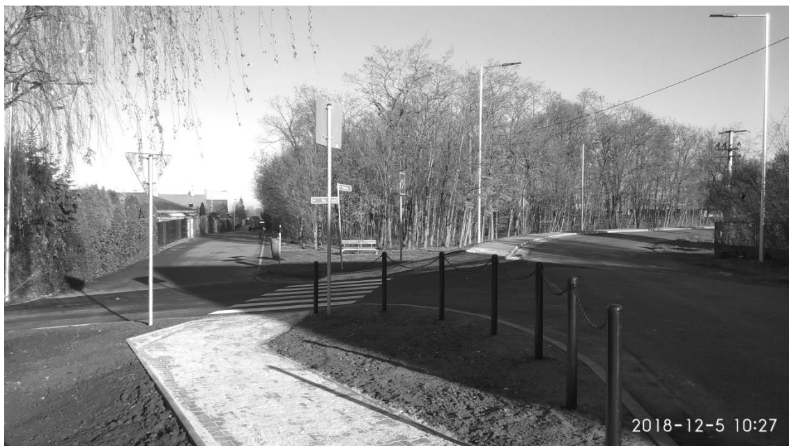
Křižovatka ulic Na Jaroši, Pod Hřištěm a Kojetická po rekonstrukci
