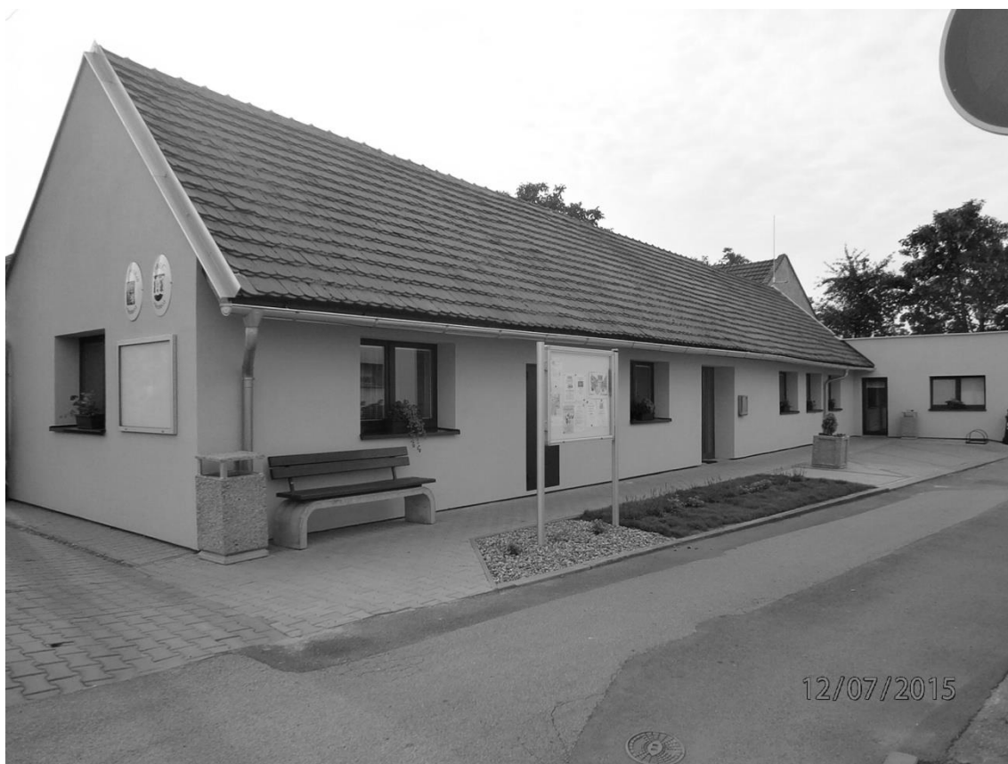
Opravená a zateplená budova obecního úřadu
